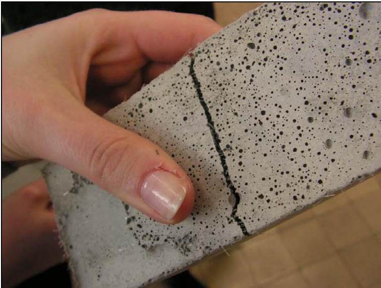
Abb. 17: Bruchstelle der stahlfaserbewehrten Betonprobe nach Prüfung auf Biegezugfestigkeit, Foto: Anica Bauer, 2008
